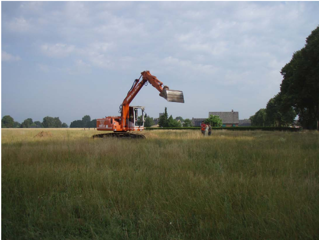
Afb. 3 Het graafwerk langs de Koksgoedweg begint.
